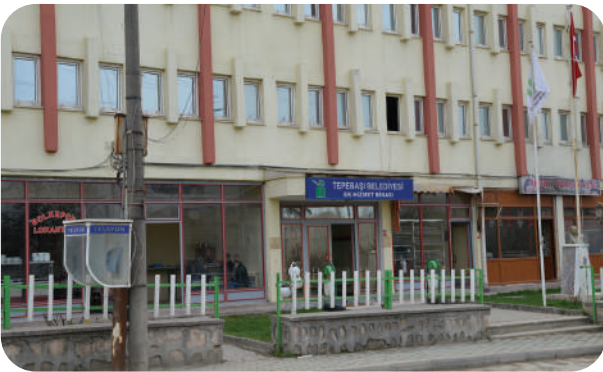
TEPEBAŞI BELEDİYESİ ÇUKURHISAR BELDE EVİ Çukurhisar Mh. Atatürk Cd. Belediye Ek Hizmet Binası No:3
