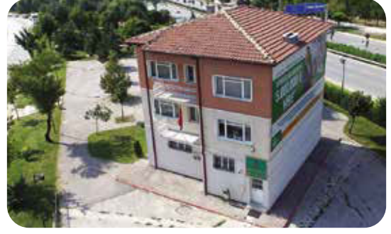
TEPEBAŞI BELEDİYESİ HASAN-ÂLİ YÜCEL BELDE EVİ Batıkent Mh. Gerekli Sk. No:1 Tel: 0222 320 12 19
