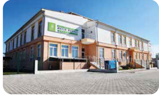
TEPEBAŞI BELEDİYESİ METİN ÖZÖĞÜT YAŞAM VE BAKIM MERKEZİ Zincirlikuyu Mh. Demetgül Sk. No.7
