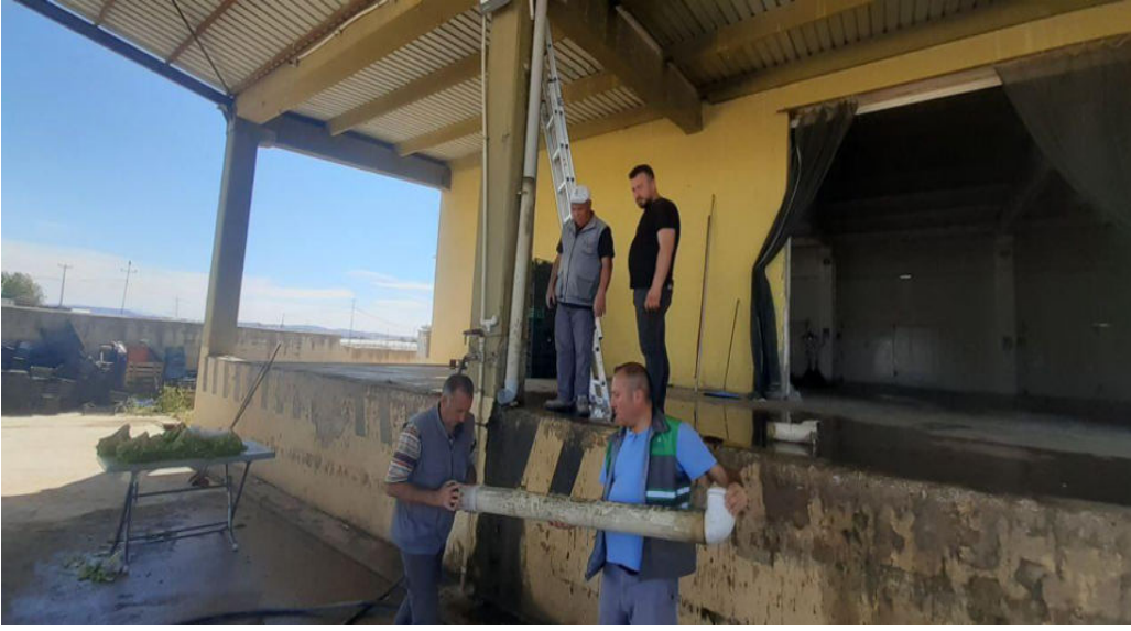
Sakintepe Soğuk Hava Deposu
