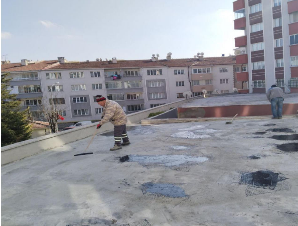
Tunalı Belde Evi Çatı Yalıtım İşi
