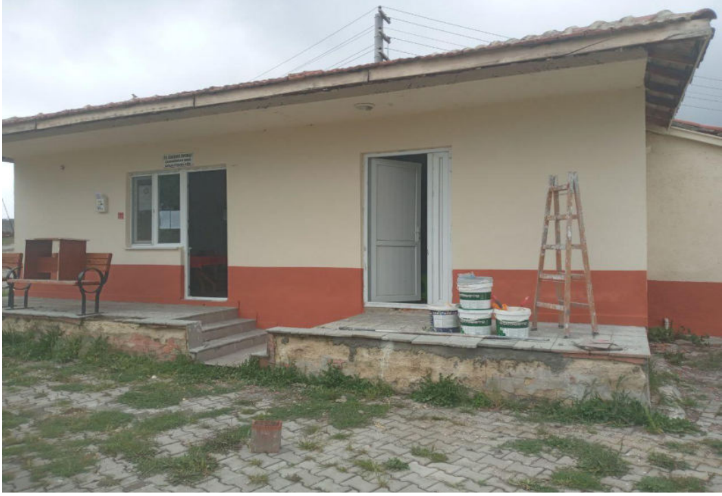
Çanakkıran Mah. Muhtarlığı Boya İşi
