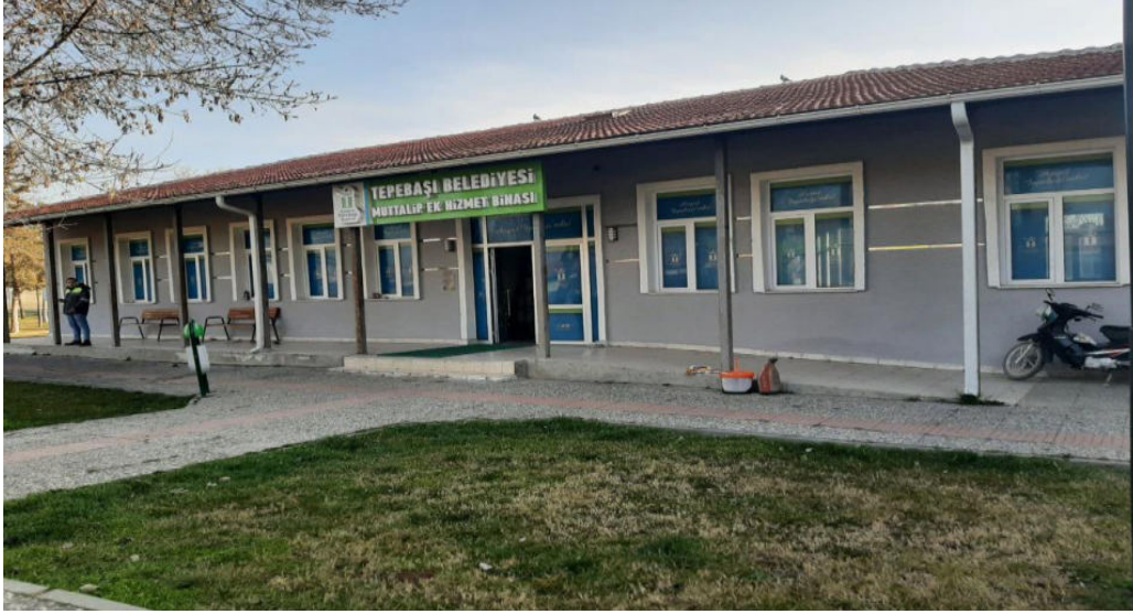
Muttalıp Ek Hizmet Binası
