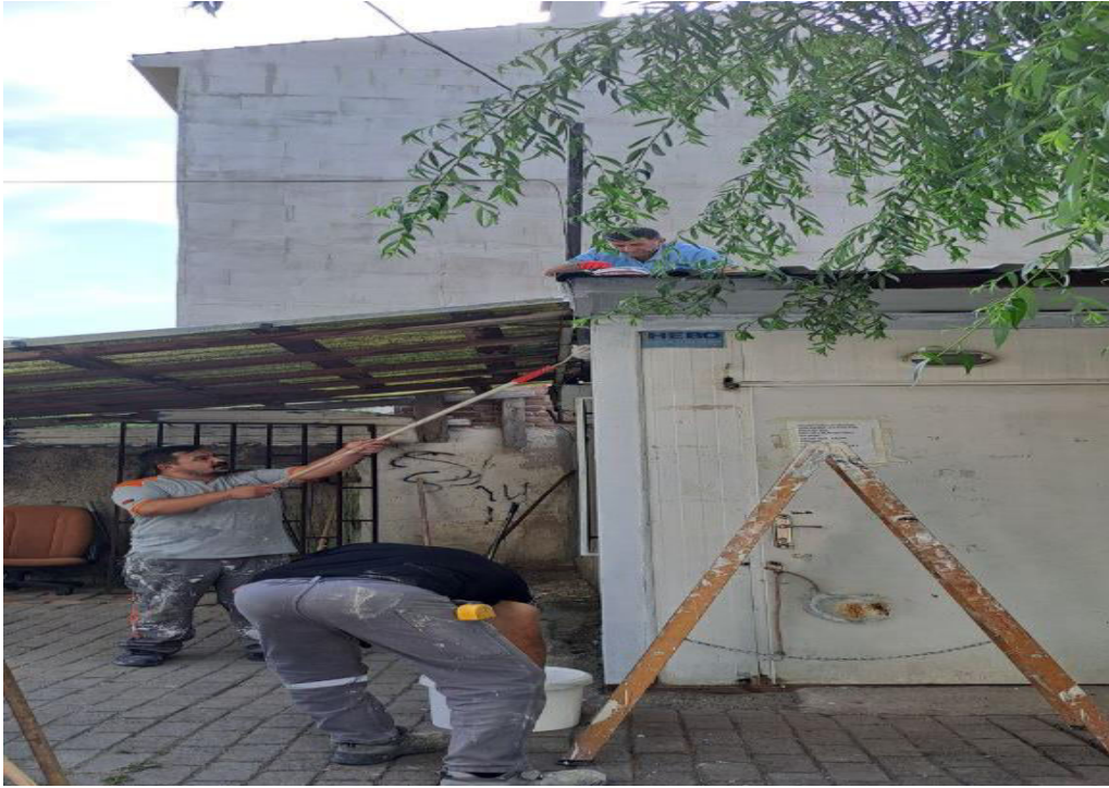
Zafer Mah. Muhtarlığı Boya İşi
