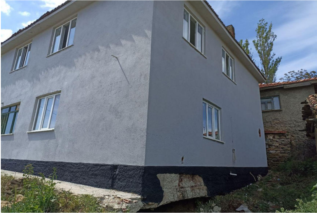
Bozdağ Mah. Muhtarlığı ve Belediye Binası Boya İşi
