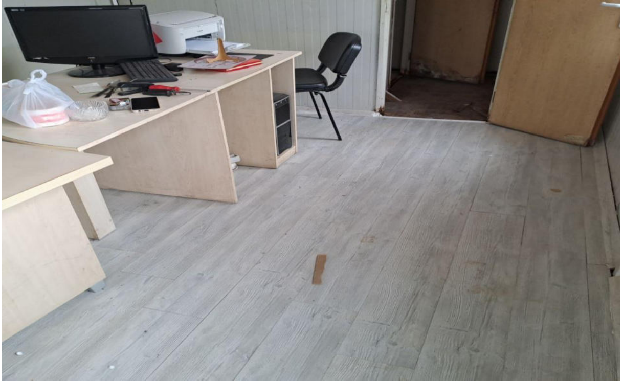
Gazipaşa Mah. Muhtarlığı Laminant Parke Yapımı İşi
