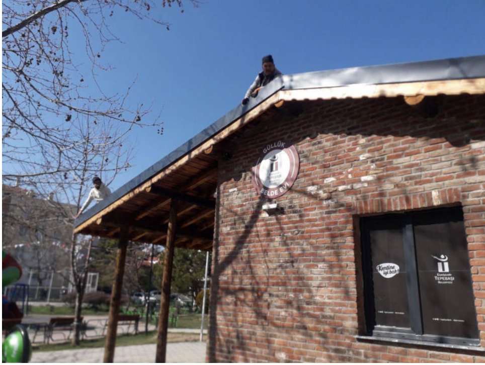
Tunalı Belde Evi Çatı Yalıtım İşi
