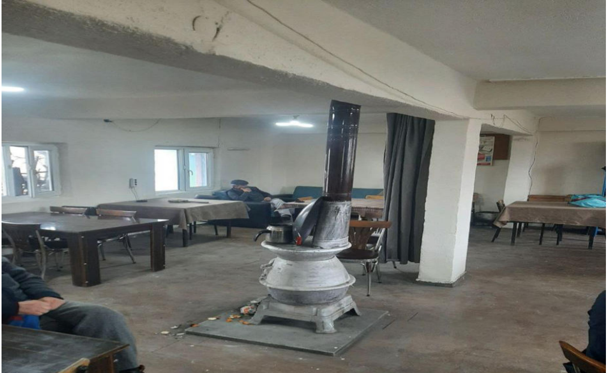
A.Söğütönü Mah. Muhtarlığı Boya İşi
