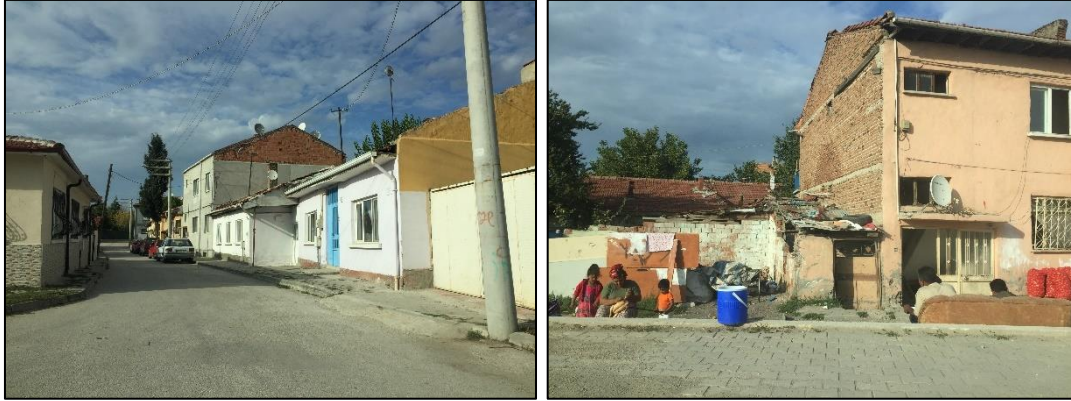
Fotoğraf 10: Yapı Kalitesi
