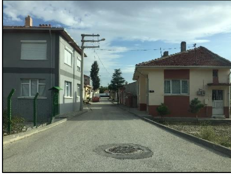
Fotoğraf 8: Yapı Kullanımları
